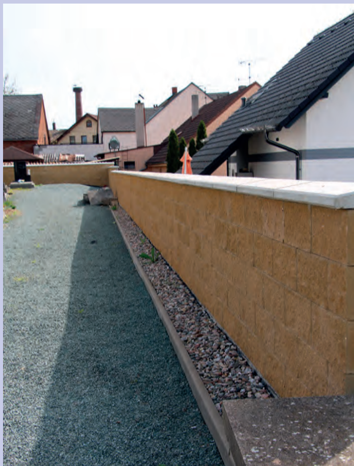
Dokončena další etapa opravy hřbitovní zdi
