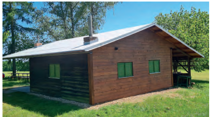
Zrekonstruovaná chata na Třešňovce
