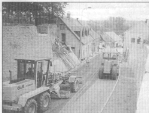
Úpravy chodníků, silnice a opěrné zdi v ulici Komenského.
