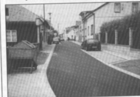
Práce byly zahájeny v dubnu 2005 a hodnota díla je 1.513.000,- Kč.
