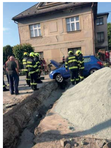
Řidič Škody Fabie nedbal zákazu a skončil zaparkovaný ve výkopu. FOTO: Archiv JSDH Častolovice
